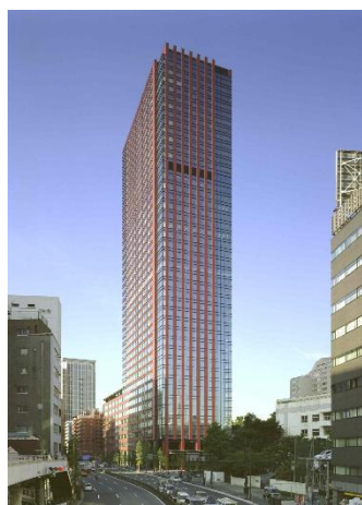
住友不動産東京三田サウスタワー
